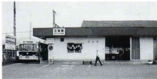
電車が発車すると急に静けさにつつまれる五條駅。その駅舎の横からJRバス阪本線が発車する。
